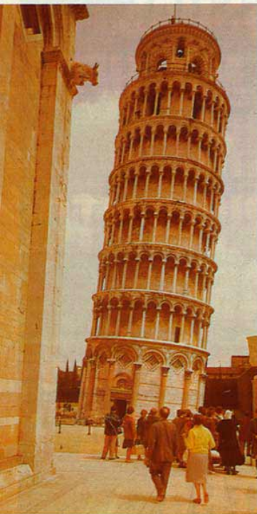
Inclinação já alcança 5,2 metros
