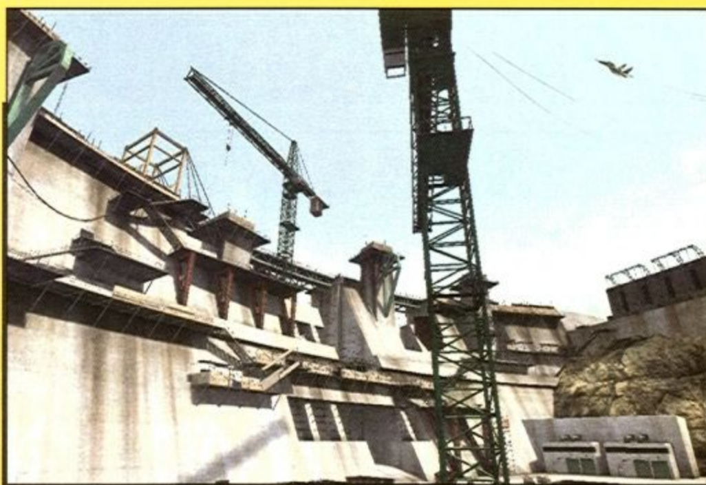
▲施工中的大壩，即將變成戰區。
