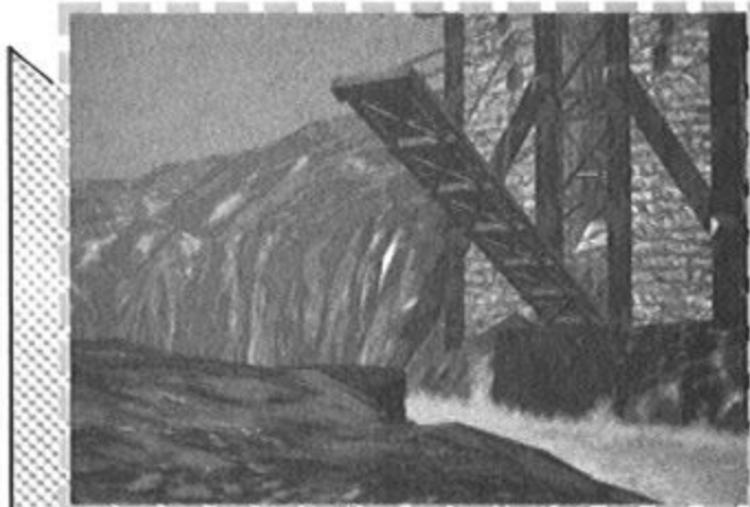
降下根之地入口吊橋
