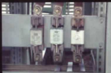
F8. Uma das fases deste sistema trifásico está com excesso de carga, causando sobreaquecimento.
