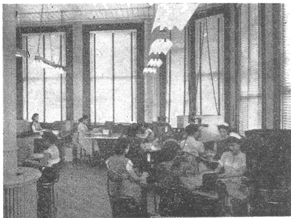
Fig. 6 — Outra vista de um dos salões da fábrica. Chamamos a atenção do leitor para a iluminação profusa que predomina em todos os ambientes.
