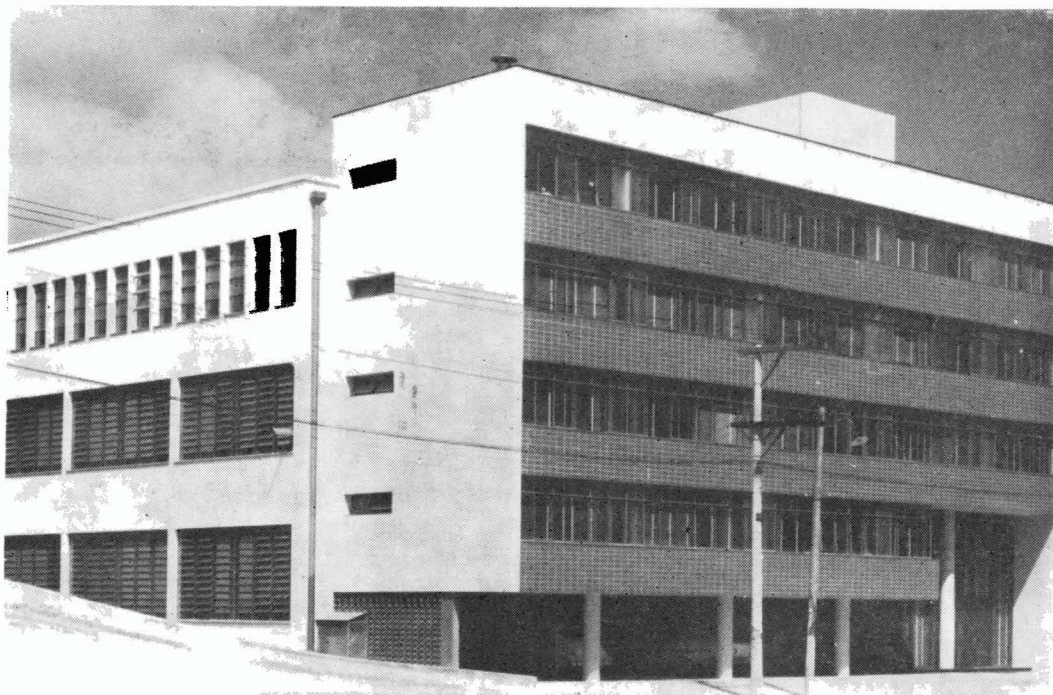
Vista parcial da fachada da moderna fábrica da Constanta Eletrotécnica S. A., em Ribeirão Pires, estado de São Paulo.
