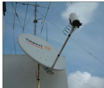
Foto 2. Parábola tipo offset con iluminador Helix de 1.7GHz para recibir el Meteosat de EA4CAX.
