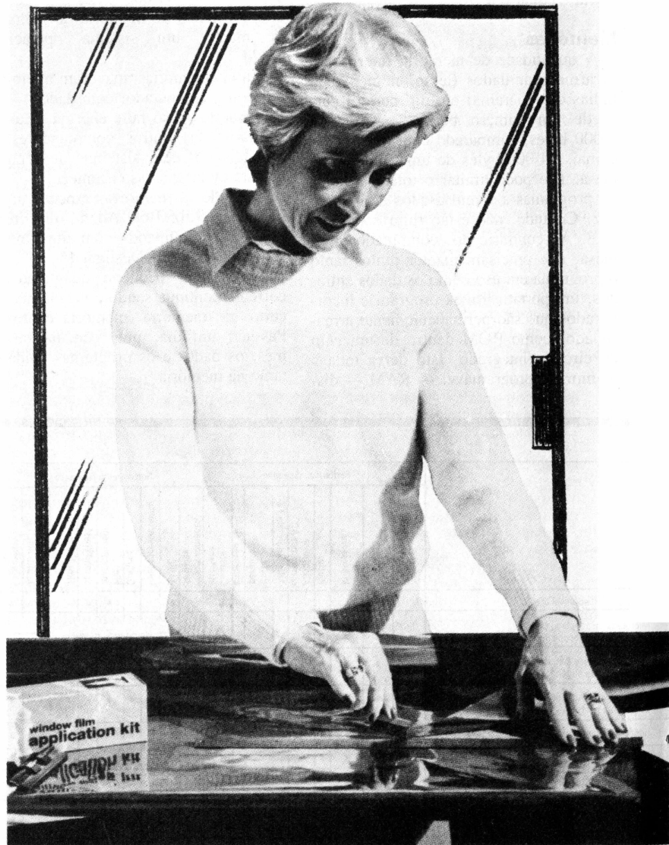
A película plástica — última palavra da tecnologia — é cortada no tamanho certo e aplicada na janela com água e sabão, que ativam o adesivo.
