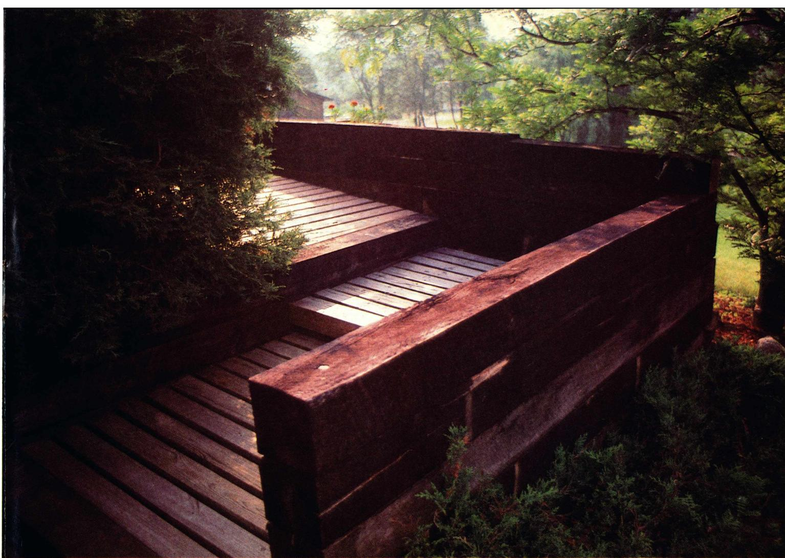
**A passagem da entrada de carro** para a frente da casa está na foto acima. O meio degrau foi obtido mediante um módulo de tamanho menor, quadrado, cujo lado mede 1,20 m. A foto à esquerda mostra a passagem pronta, rodeada pelas jardineiras com plantas de folha perene, e por um leito de lascas de casca de pinheiro. Debaixo das pranchas há uma folha de plástico preto de 6/1000" de espessura. A limpeza da fossa séptica é feita pelo centro da passagem, através de um módulo desmontável.
