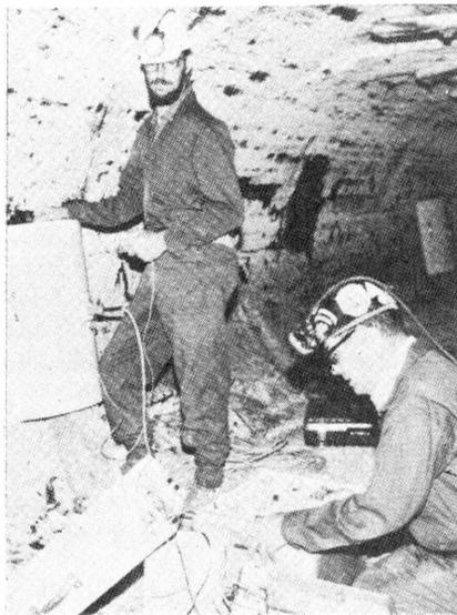
As surpresas encontradas nas minas podem ser mortais. Este radar sonda a terra, localizando falhas e poços abandonados que podem provocar inundações, escape de gases, ou desabamentos.
