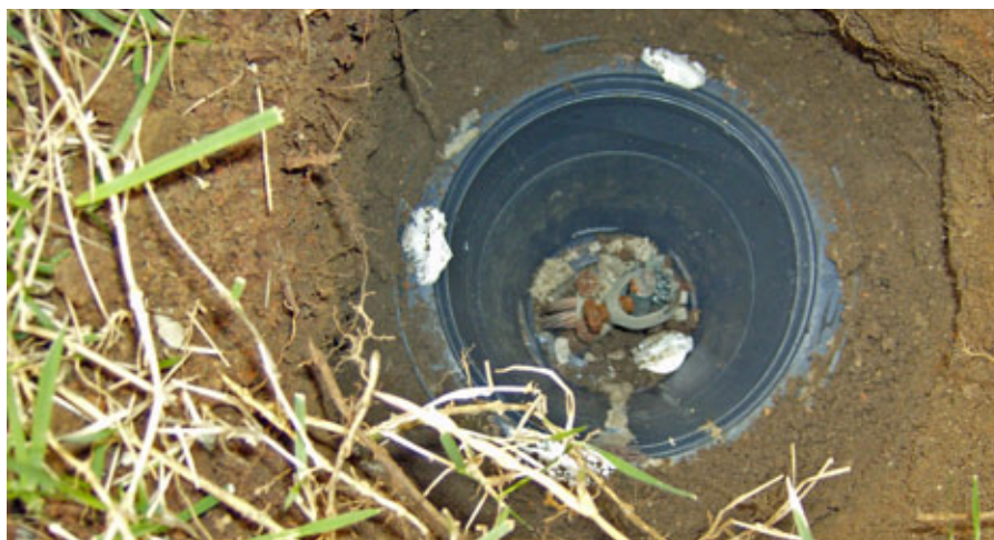
F2. Detalhe de uma caixa de inspeção para acesso às hastes e conexões do sistema de terra.
