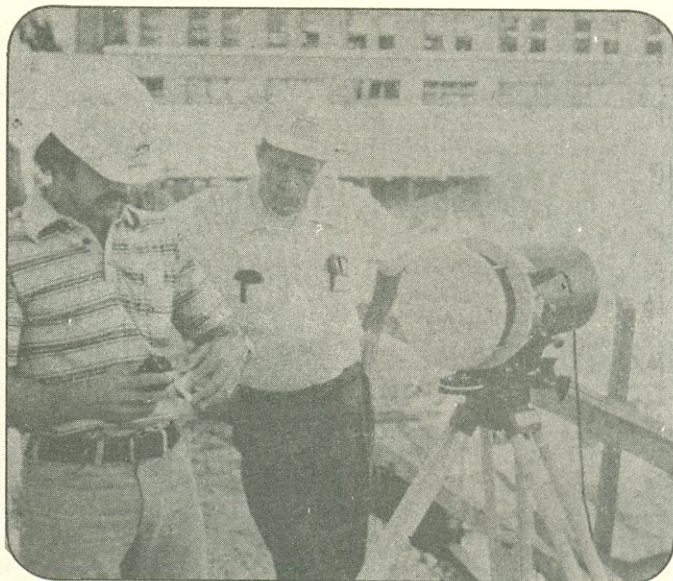
Outra aplicação corriqueira do transmissor rotativo, aqui fornecendo um plano vertical na construção de um edifício.
