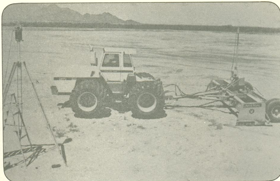
Exemplo de aplicação do sistema a laser na terraplanagem. Observe o mastro, soldado sobre a lâmina do trator, e o transmissor, à esquerda, montado sobre um tripé.
