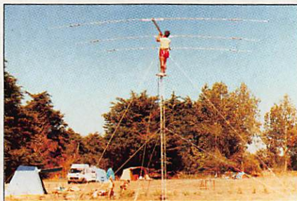
Installation des aériens décimétrique
