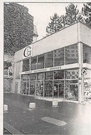
Le nouveau magasin, vue Générale (!)
