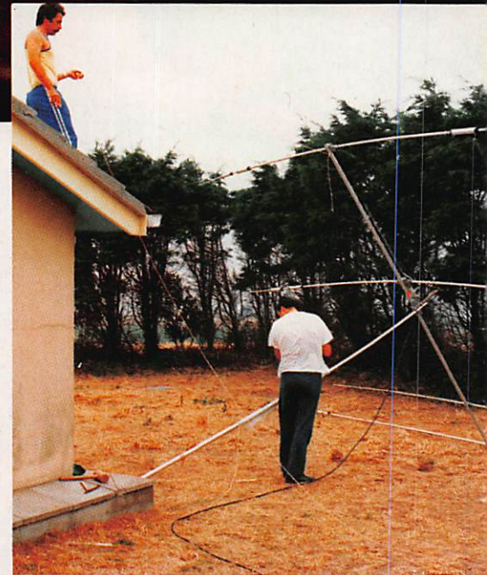
F2CW (perché !) et F6GKQ au démontage des antennes.
