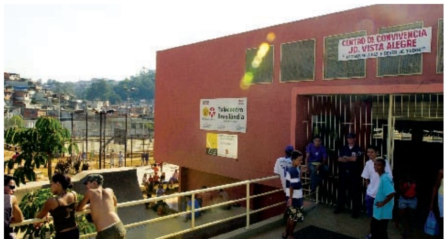
Figura 3: Entrada do Telecentro Brasilândia.
