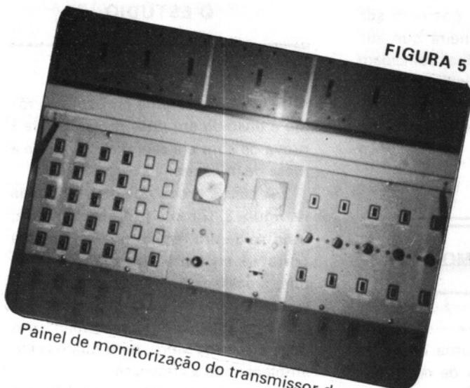
Painel de monitorização do transmissor de 50KW.
