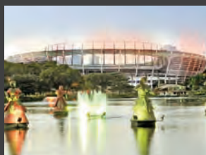
Salvador O Fonte Nova terá cobertura feita de cabos tensionados que usam pouco aço
