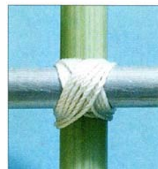
Bild 12: Einfache Befestigung der Elemente auf dem Querträger mit einer 1,5 mm dicken Schnur Fotos: DG0KW
