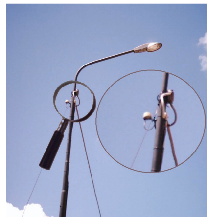
Figura 6: Foto di un crepuscolare che pilota l'accensione della illuminazione pubblica
