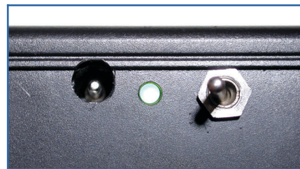
Figura 12: Ecco come appare il pannello dopo l'installazione dei tre componenti
