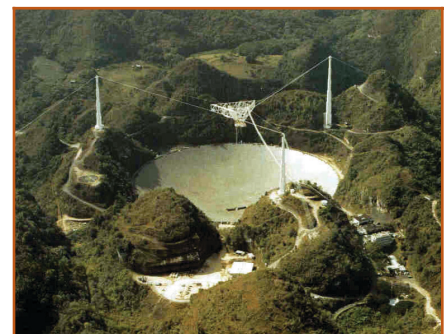
Figura 5b: Il grande radiotelescopio di Arecibo (Porto Rico) è formato da un'enorme antenna a parabola ricavata all'interno di un cratere di oltre 300 metri di diametro
