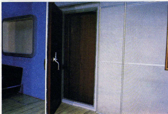
ABAIXO: detalhe do revestimento acústico de um cenário (placas absorventes nas paredes).
