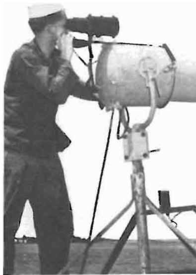
Fig. 4 - Le comunicazioni ottiche navali: ieri: telegrafo ottico morse; Oggi trasmissione voce/dati a raggi infrarossi.
