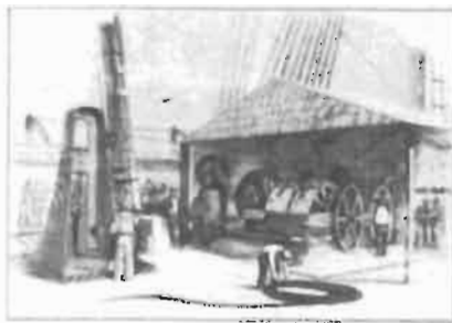
Fig. 2 - Il macchinario installato per la posa del cavo installato sul ponte dell'Agamemnon.
