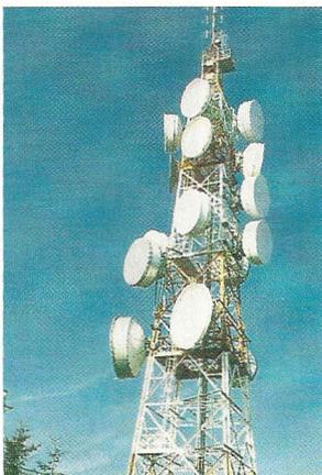
Para reduzir ao mínimo os **efeitos do terreno** e das construções adjacentes, as antenas transmissoras são situadas normalmente na parte superior de torres especiais.
