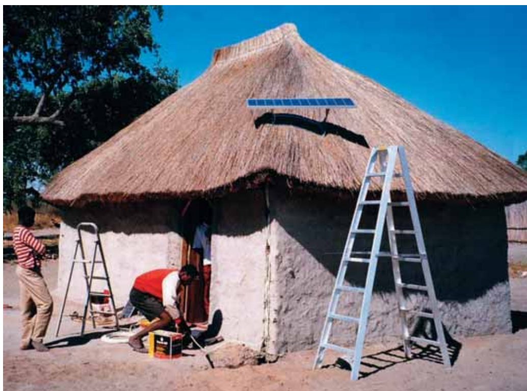
Figura 1. Un sistema con un panel solar aislado proporciona un cierto grado de independencia de la tensión de red (Foto: Pocos).
