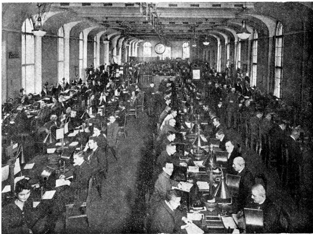
Sala de acústicos de la Central de Telégrafos de Berlín. En este departamento entran los hilos de poblaciones de poco servicio. Para su distribución a los aparatos hay cuatro pequeños conmutadores que figuran debajo del reloj. Desde dichos conmutadores puede el jefe vigilar la actuación de cada funcionario. En cada turno entran de servicio en esta sala 220 telegrafistas.
