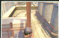
26 No capítulo 10. Ao entrar no andaimes, no telhado.
