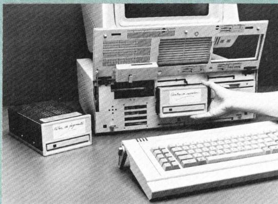
Nexus 4600 tem sistema plug in, facilitando a remoção de periféricos
