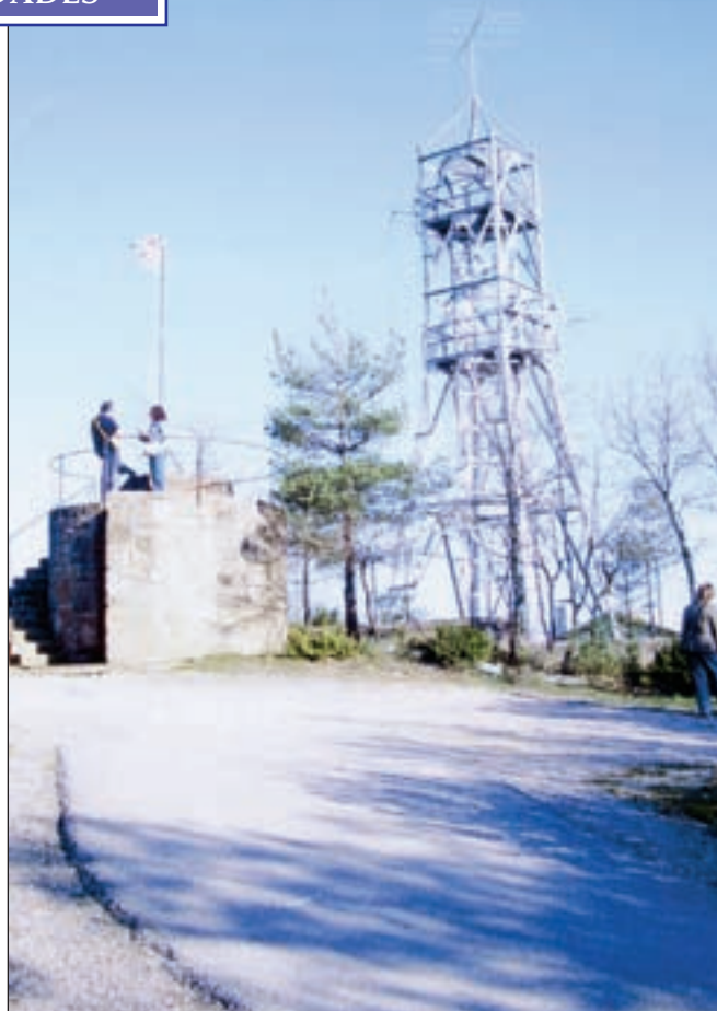
Foto A - Torre de 20 m, situada junto a la pilastra que señala el centro geográfico de Cataluña, en el cerro del Santuario de la Virgen de Pinós, a 930 m de altura.
