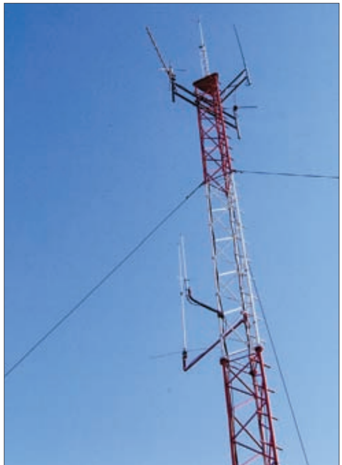
Foto C. En esta torre triangular de 18 m están instaladas las antenas, entre otras, del repetidor R71, de amplia cobertura.
