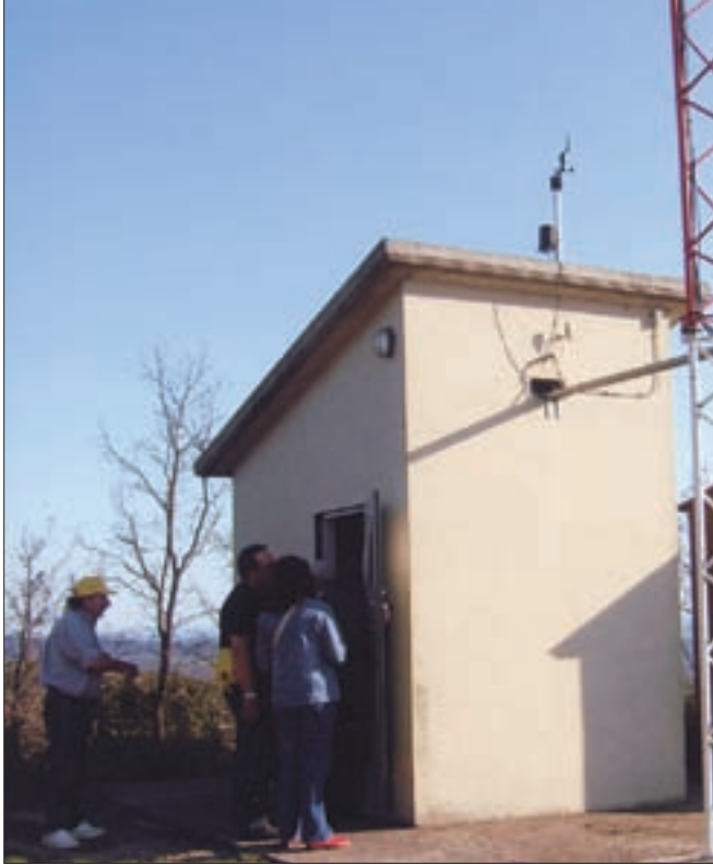
Foto D. El repetidor R-71 y otros instrumentos están a cubierto de la intemperie en esta sólida caseta.
