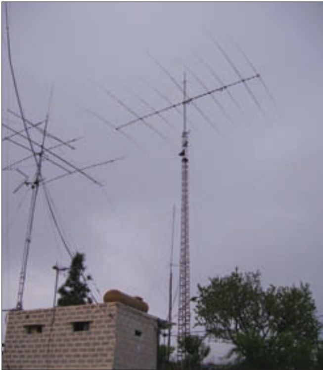
Sobre una torre autoportante de 22m se dispone de una formación de dos antenas monobandas: 3 elementos para 40 m y 6 elementos para 20 m.
