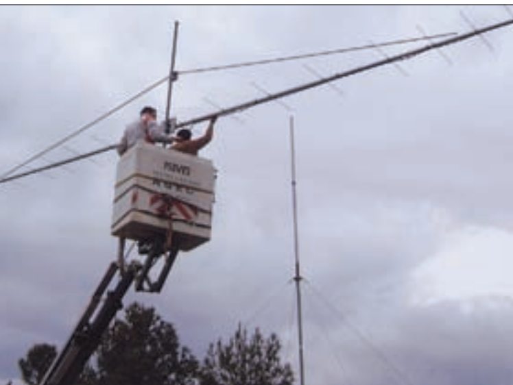
Foto E. La mejor manera de instalar una antena de 21 elementos, cuando se tienen los medios y la oportunidad de hacerlo, es usar un camión-grúa. Los miembros de la ARS lo hicieron así.
