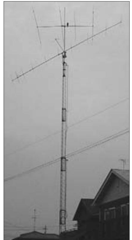
Fotos A y B. La antena Yagi de 10 elementos para la banda de 6 metros de JM1DTF, a una elevación convencional de 0 grados (A), y elevada a 30 grados (B).
