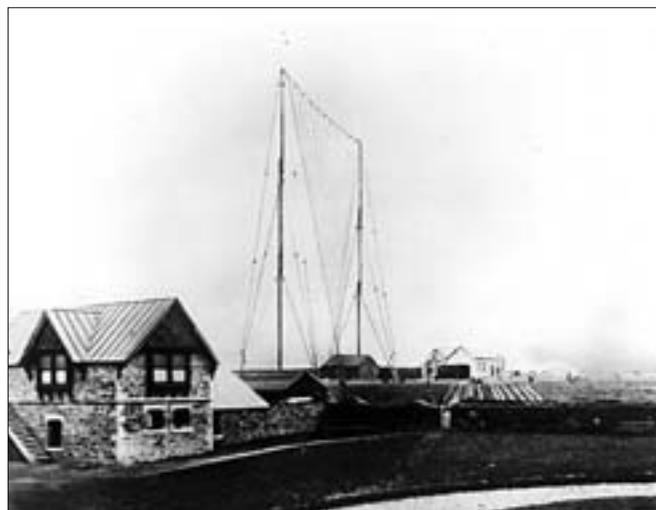
Foto C. Ésta es la antena de abanico con la que se intentó la comunicación trasatlántica. Hay que advertir que la foto fue retocada y muestra sólo 12 hilos, cuando en realidad tenía 54. (Fuente: [www.oldradio.com/archives/](http://www.oldradio.com/archives/))
