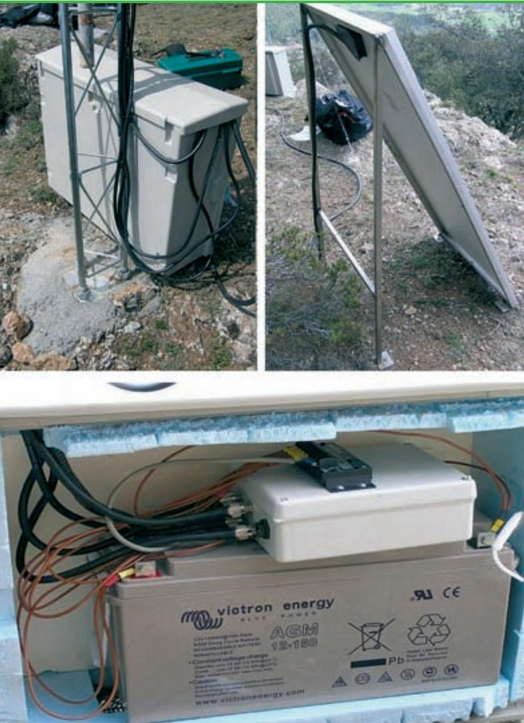
Foto C. La creación de enlaces inalámbricos con tecnologías Wireless o WiMAX, dotados de placas solares y baterías, nos permitirán disponer de autonomía en caso de fallo de suministro eléctrico y ofrecer ciertas garantías en caso de catástrofe.
