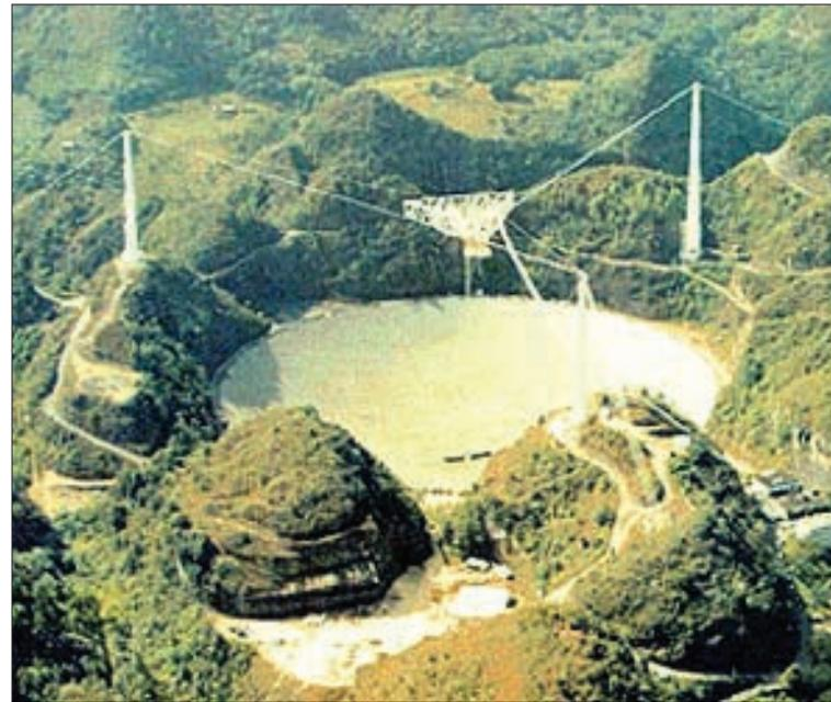
*El radiotelescopio de Arecibo está formado por una parábola fija en el fondo de un valle, por encima de la cual se desplaza el iluminador.*
