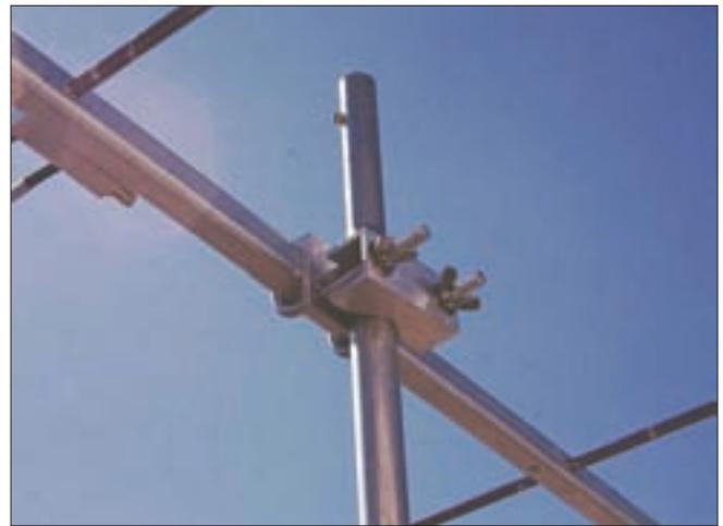
Foto E - Eliminar la necesidad de herramientas para el montaje y desmontaje es siempre una cualidad interesante en las operaciones portables esporádicas.
