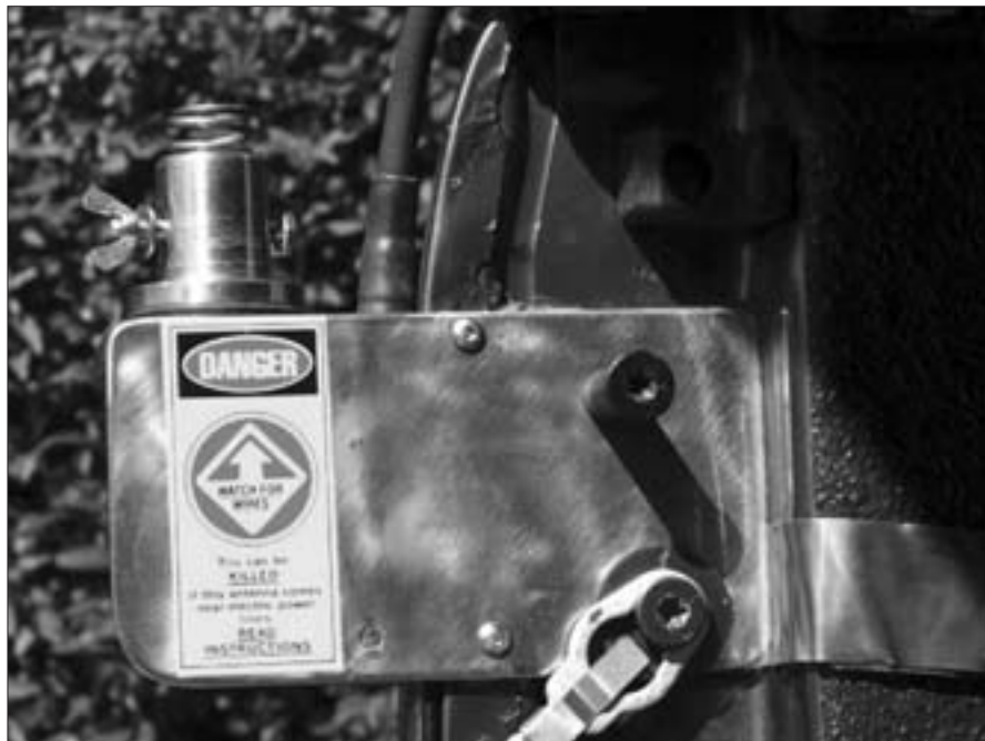
Foto D. Detalle de la instalación del soporte de la antena. Se hicieron agujeros en la placa para que coincidieran con unos ya existentes en el marco.
