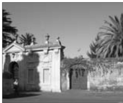
Esta es la sede de la estación 1A4A, que estuvo en el aire el pasado mes de enero. (Foto cortesía de Rick, NE8Z)
