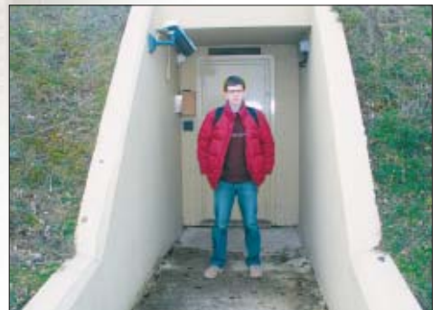
Wejście chroni gruba warstwa zbrojonego betonu oraz śluz powietrzna między podwójnymi pancernymi drzwiami
