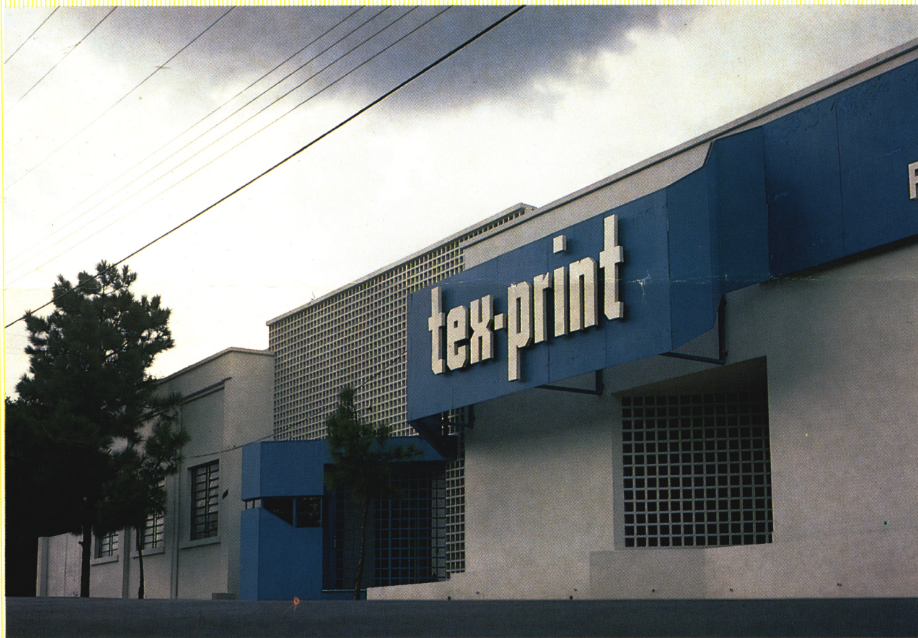
Vista parcial da nova fábrica em Campinas - SP
