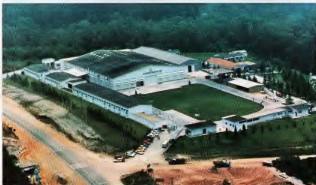
Fábrica de potenciômetros e resistores de fio, localizada em Ribeirão Pires, SP.
