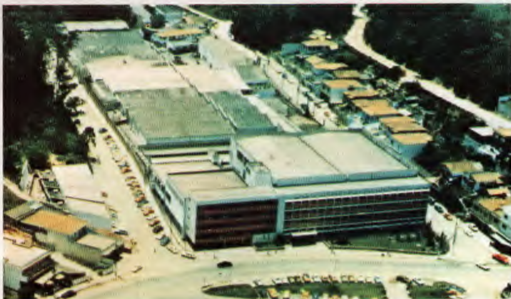
Instalações dos escritórios centrais, metalúrgica e fábricas de cerâmica branca, resistores de filme e capacitores. Ribeirão Pires, SP.
