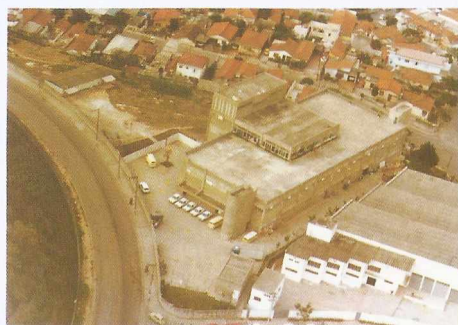
Mutinga I, com apenas parte do prédio construída
