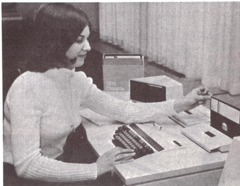
**Fig. 24.** – Um sistema “teclado para disco”, consistindo num visor, num teclado, e num sistema de disquette.
