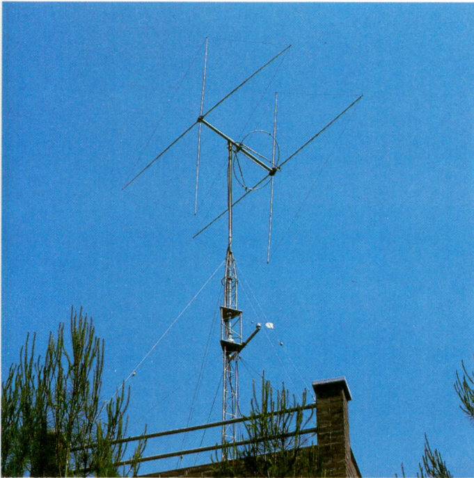
Antena cúbica tipo Quad; se trata de otro tipo de antena empleada por los radioaficionados en algunas ocasiones.
