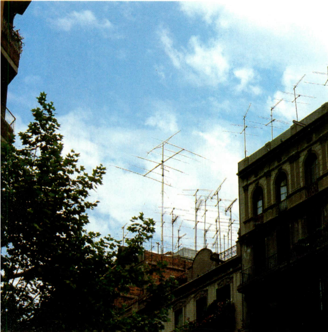
De entre el bosque de antenas de TV (UHF-VHF) sobresale una antena direcciva de HF para la banda de la radioafición.
