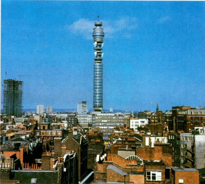
Torre de telecomunicaciones de la British Telecom. Esta torre está situada en el centro de Londres y comprende sistemas de enlace por microondas y otros tipos de antenas direccionales.
