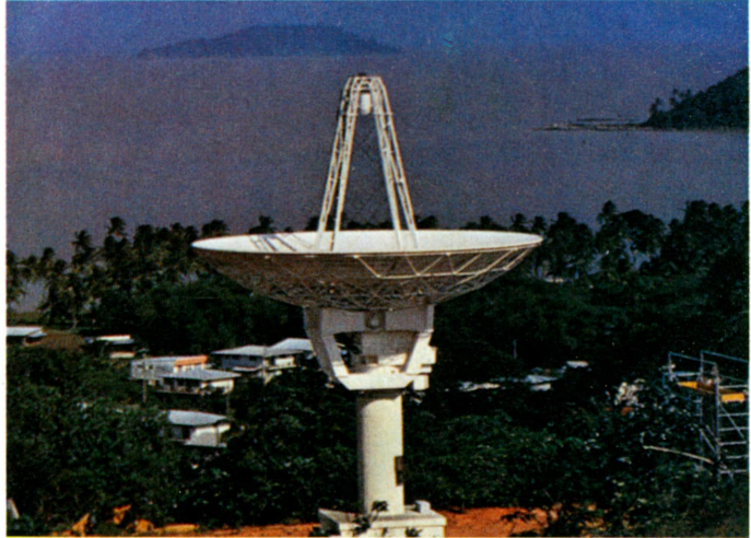
Antena de enlace vía satélite. Son parábolas de gran tamaño que utilizan como repetidores satélites geoestacionarios.
