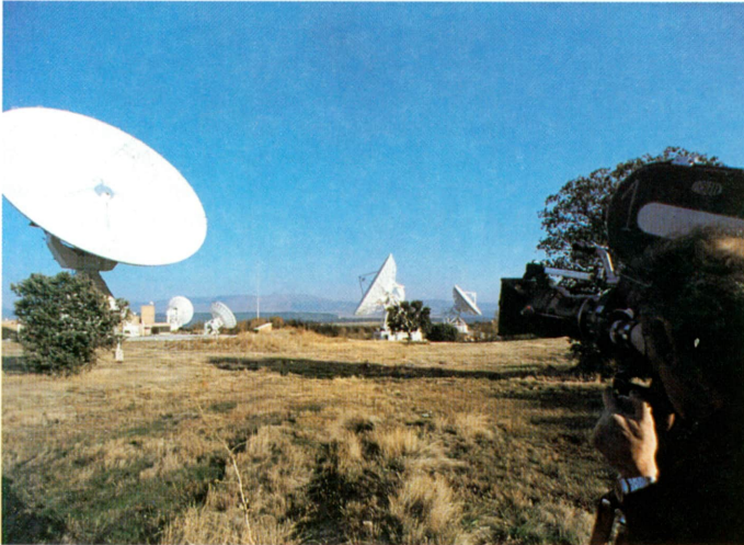
Estación terrena de comunicaciones vía satélite. Obsérvese la gran cantidad de parábolas de gran tamaño, lo que permite trabajar con niveles de señal muy pequeños.
