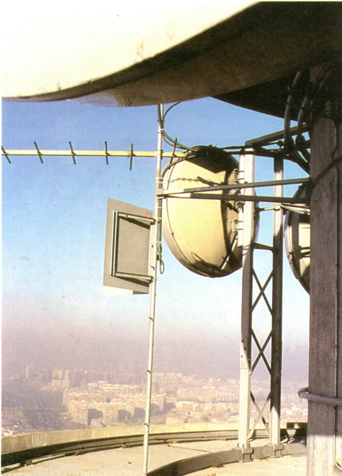
Grupo de antenas que existen en las proximidades o sobre las emisoras de televisión. Se observan antenas de FM, VHF, UHF, parábolas de enlace terrestre por microondas, y una parábola mayor para la recepción y transmisión vía satélite. (Cortesía: TVE).
