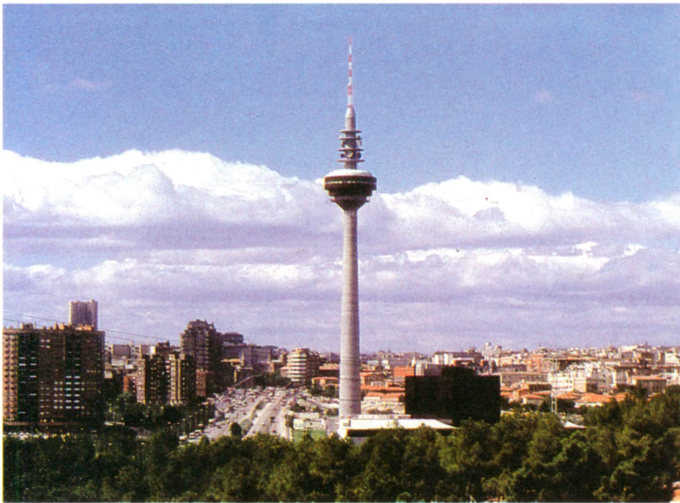
El famoso «piruli» de los estudios de Torrespaña que tiene TVE en Madrid. En la parte superior se sitúan los enlaces hercianos con toda España, y los paneles radiantes para la zona de Madrid.
