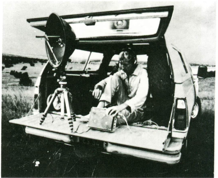
Figura 48. Los concentradores de sonido, permiten alejarse del foco sonoro y recoger sonidos en una dirección concreta.
