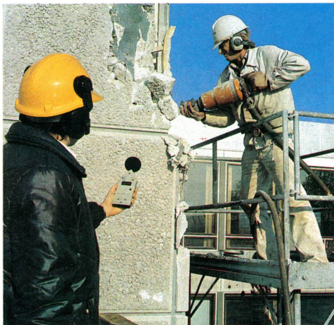
Aplicación de un sonómetro, destinado a medir el nivel sonoro en decibelios, en una operación de demolición para comprobar si el ruido ocasionado queda dentro de los límites permitidos por las ordenanzas municipales.
