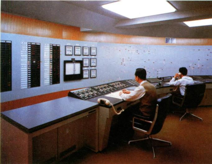
*Las grandes instalaciones industriales, como centrales eléctricas, centros de control de ferrocarriles, etc., requieren amplios cuadros capaces de reflejar a simple vista la actuación en los diferentes puntos donde se establecen los controles de funcionamiento. En inglés se denominan salas «dispatching».*
