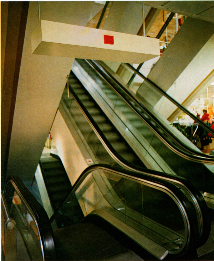
Instalación de un sistema "overhead" en un punto estratégico de unos grandes almacenes, para detectar el hurto de piezas que lleven incorporado el sistema de seguridad y que pasen por debajo del mismo. Existen dos sistemas de alarma, radioeléctrico y magnético, siendo este último el más utilizado.
