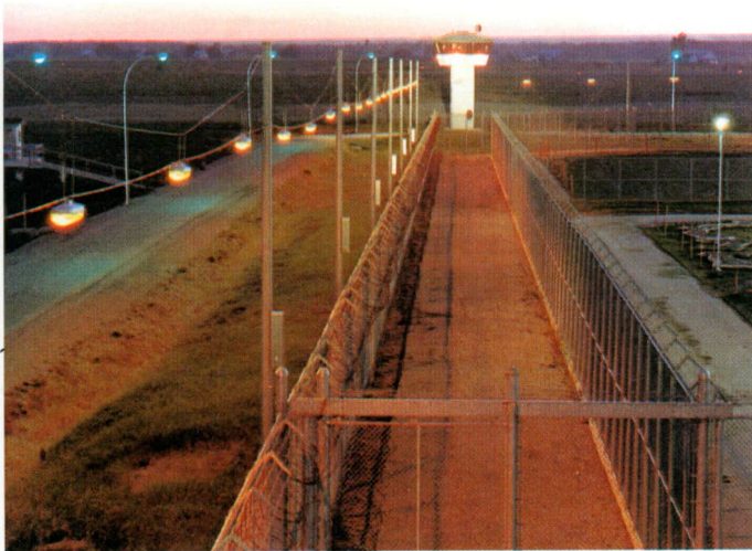
Alambrada de seguridad en torno a una prisión en las inmediaciones de Toronto (Canadá). Hay sensores enterrados y en las vallas metálicas.
