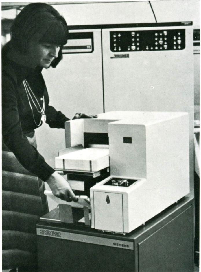
*Figura 19. Lectora de tarjetas con marcas ópticas. El sistema más cómodo para la introducción de datos codificados en el computador, sin estar frente a un terminal.*
