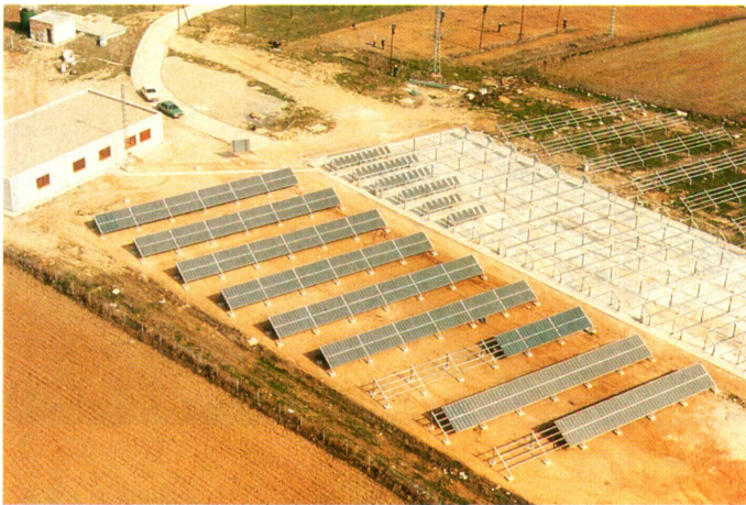
Primera central solar fotovoltaica experimental en San Agustín de Guadalix, cerca de Madrid, obtenida íntegramente con tecnología nacional. Tiene una potencia instalada de 100 kWp y está ejecutada por Standard Eléctrica, Hidrola y Asinel, además de varios departamentos de las universidades Autónoma y Politécnica de Madrid. Se han empleado células de silicio monocristalino y silicio amorfo.
