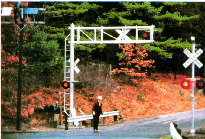
En Massachusetts, dos sistemas, uno de 20 Wp y otro de 36 Wp alimentan los circuitos de aviso luminoso y las campanas de alarma de un paso a nivel.
