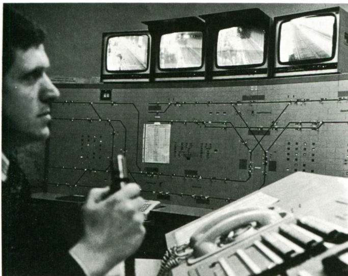
Las nuevas tecnologías juegan un papel importante en el transporte. Panel central de un sistema de control de tráfico ferroviario.
