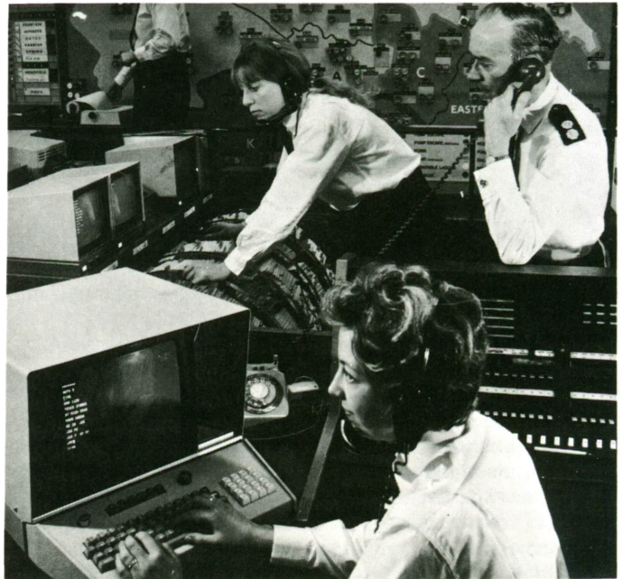
Sala de control de un sofisticado sistema de regulación y control del tráfico urbano en una gran ciudad de la R.F. Alemana.
