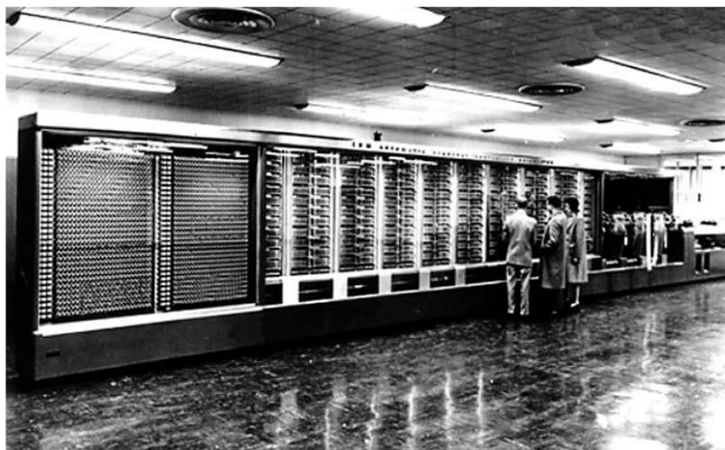
Der raumfüllende Mark I von 1944 bestand aus 750 000 Einzelteilen, 530 Meilen Kabel und 3 000 000 Drahtverbindungen und lief mit einer Taktfrequenz von 0,33 Hertz.
